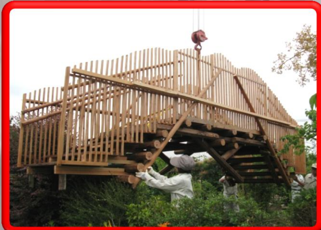
木製橋の設置実習
