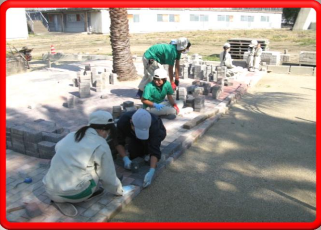
インターロッキング施工実習
